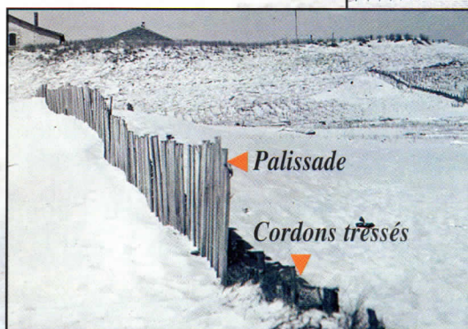
C'est Goury qui, vers 1825, a utilisé pour la première fois la palissade de planches, en remplacement des cordons de branches tressées.
