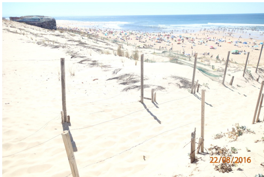
Zone de dune avec des travaux mixtes de couverture et plantation, montrant un bossellement naissant
