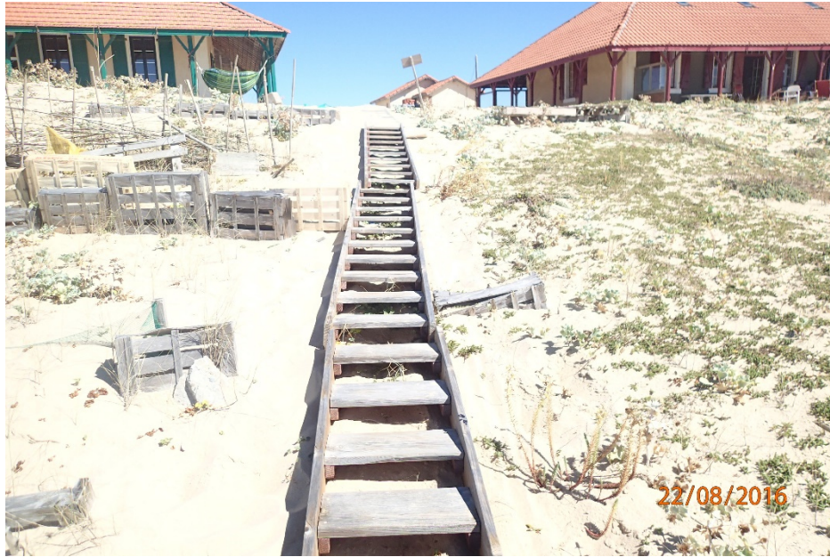
Passage de dune en escalier amovible
