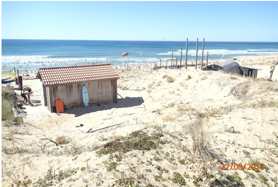
Bâtiment d'école de surf encaissé dans le versant Ouest
